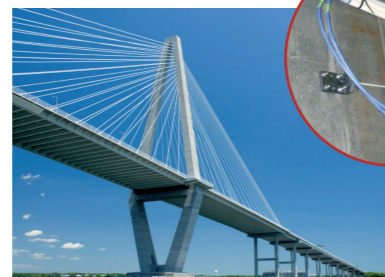
▲ surveillance d'ouvrages d'art
