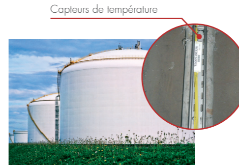
▲ Détection de fuite GNL
