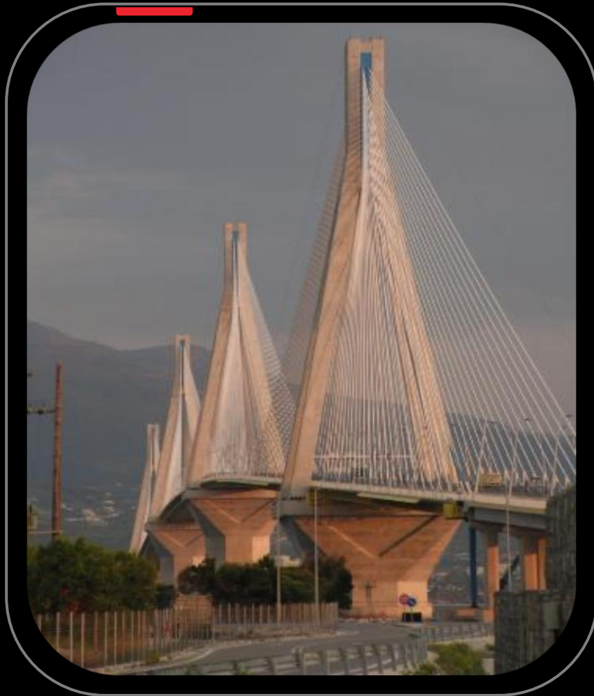
Pont haubané de RION (Grèce)
